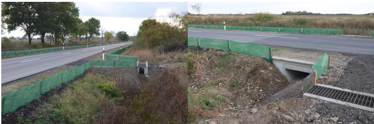
7. ábra. A szaporodóhelyek irányába vonuló kételtűeket terelőkerítéssel irányítják az út alatti átjáróhoz „békaalagúthoz” (fotó: PURGER J. J.)
